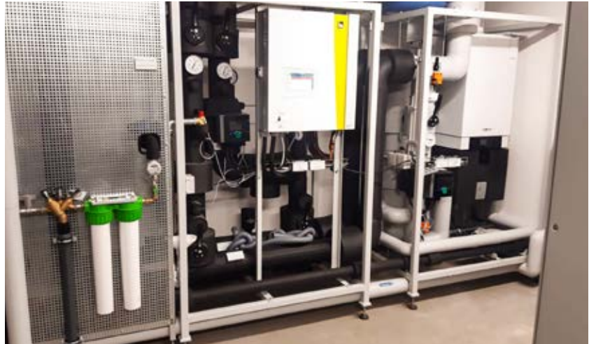
Heizen und Kühlen: Vorgefertigte Wärmeerzeuger- und Wärmepumpenmodule
