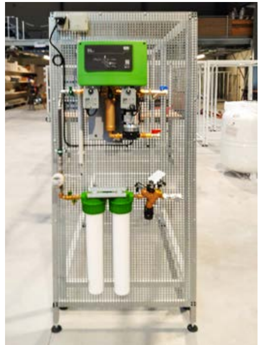
Vorgefertigte Druckhaltung mit Füllstation als Standardlösung
