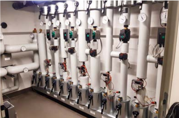
Heizen: Vorgefertigter Energieverteiler
