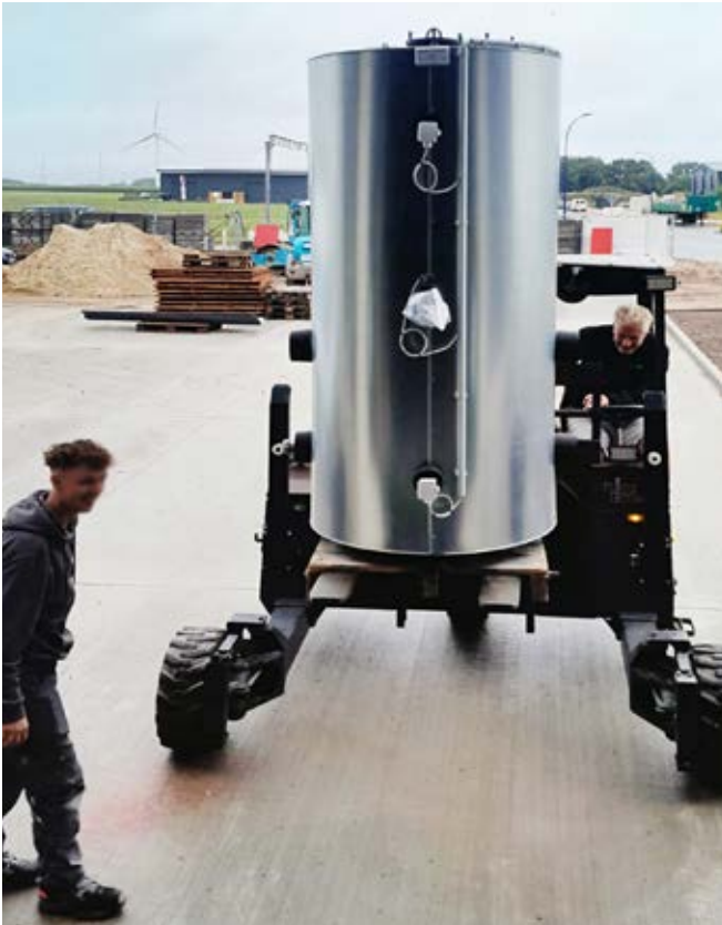
Einbringung eines vorisolierten Pufferspeichers für eine Energiezentrale
