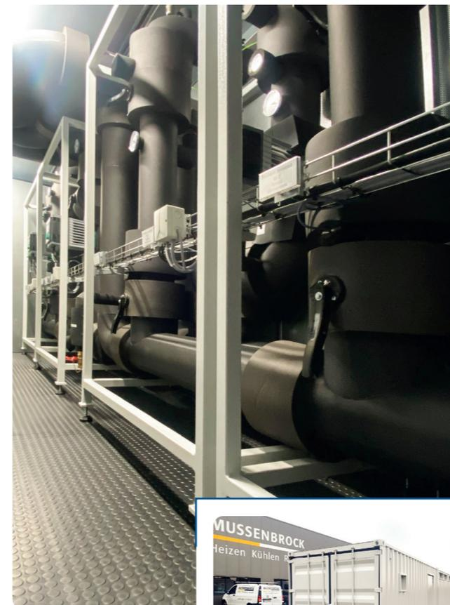
Modulbaugruppen in einer betriebsfertigen Container-Energiezentrale
