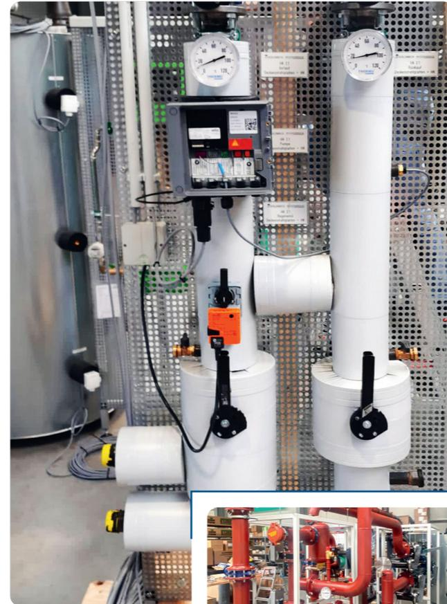
Modulare Heizkreiserweiterung für eine modulare Energiezentrale
